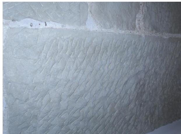
*Sandsteinquader, ca. 65cm hoch. Leicht gebogene Spuren der Zweispitzeisen (sichtbar im Attique, 3.OG.)*
