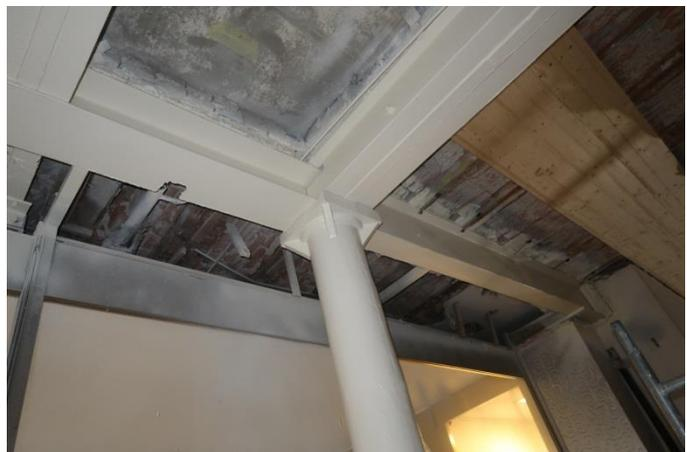
*Tragkonstruktion aus Gusseisen und Stahl von 1909 im Laden (Südteil) unter der preussischen Kappendecke von 1743, Aufnahme 28.8.2019 anlässlich des fünften Ladenumbaus*
