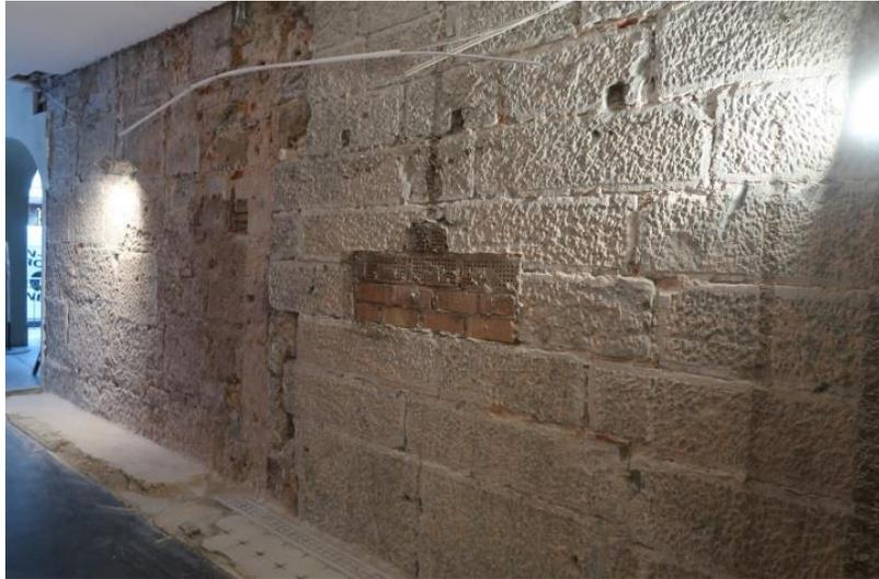
*Vestibül nach Putzentfernung, West-Wand gegen Kramgasse 56: unterschiedliche Quadersteine, bearbeitet mit Zweispitzeisen. Sichtbar die verschiedenen späteren Türstellungen und die wieder zugemauerte Lücke für die Briefkästen von ca. 1906 (Aufnahme 24.7.2020).*
